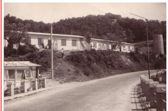
Buonalbergo: le baracche sul ponte, terremoto del 1962.
